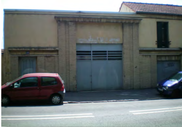
Ancienne entrée de la salle de Bal. 2012. Archives municipales de Vitry-sur-Seine
